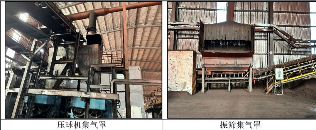
图 3-4 本项目压球生产废气集气罩
