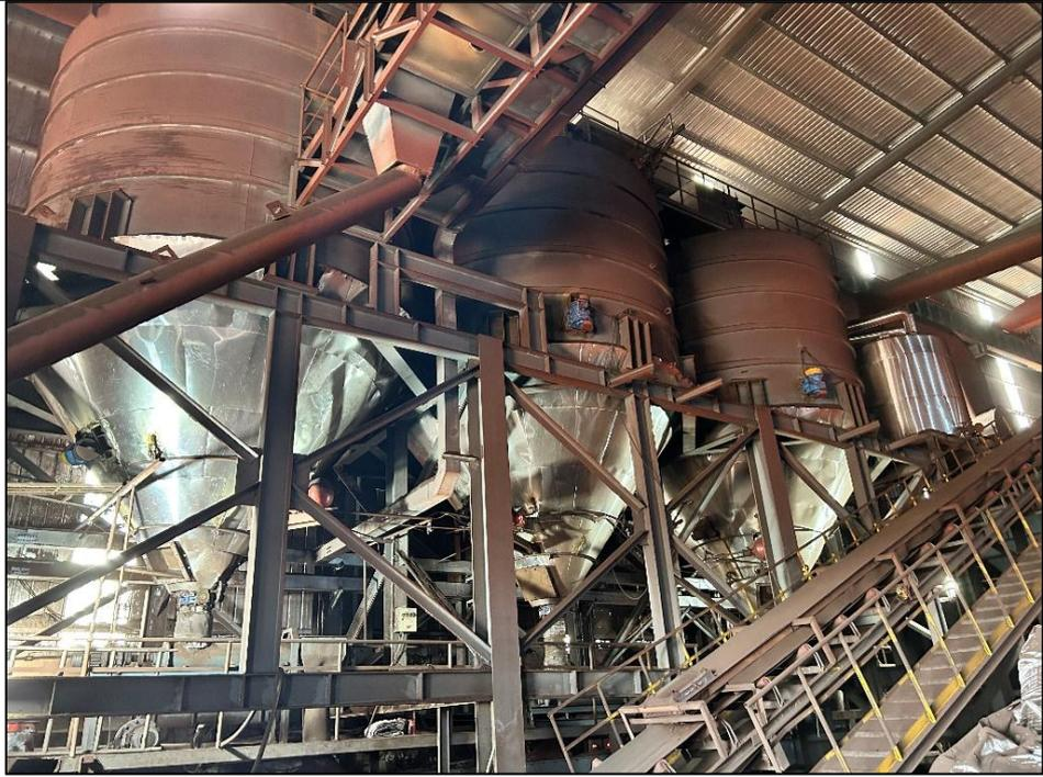
图 3-3 除尘灰仓顶高效布袋除尘器
