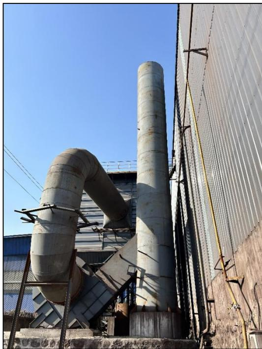
图 3-2 压球生产工序布袋除尘器配套排气筒
