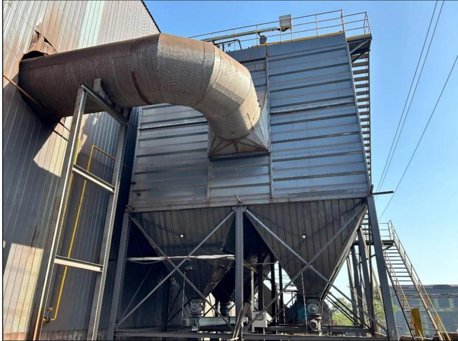
图 3-1 压球生产工序布袋除尘器
